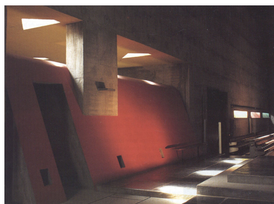
Vistas del muro de acceso a la sacristía y sus lucernarios.
