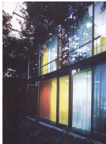
RICOLA MARKETING BUILDING LAUFEN, HERZOG AND DE MEURON CON LA COLABORACION DE ADRIAN SCHIESS EN EL MANEJO DE COLOR, 1998. ▲
